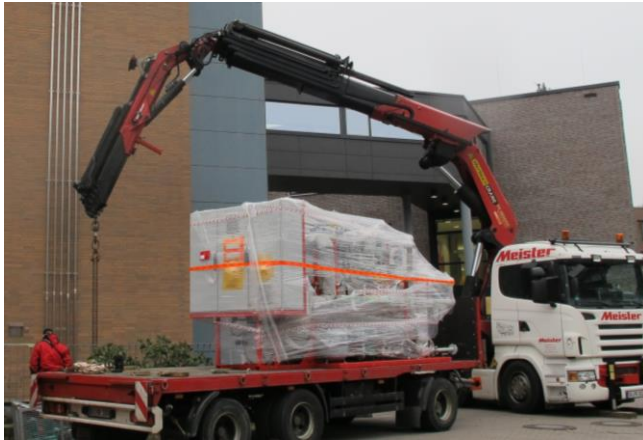
Einbringung des BHKW-Moduls mittels Spezialtransport
