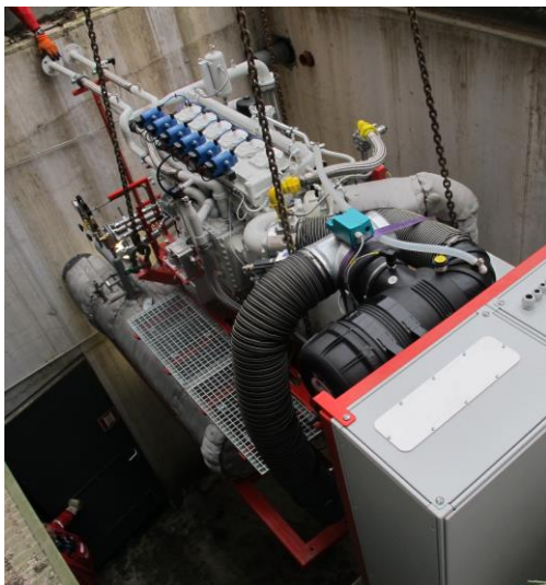
Neuer 6-Zylinder MAN-Reihenmotor mit 12,4 l Hubraum
