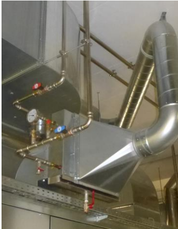
Detailansicht BHKW-Anlage Bad Soden
