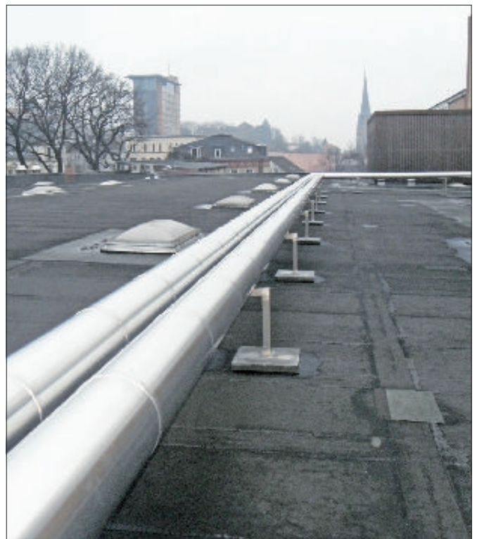
Abb. 4: Trassenführung auf den Dächern
