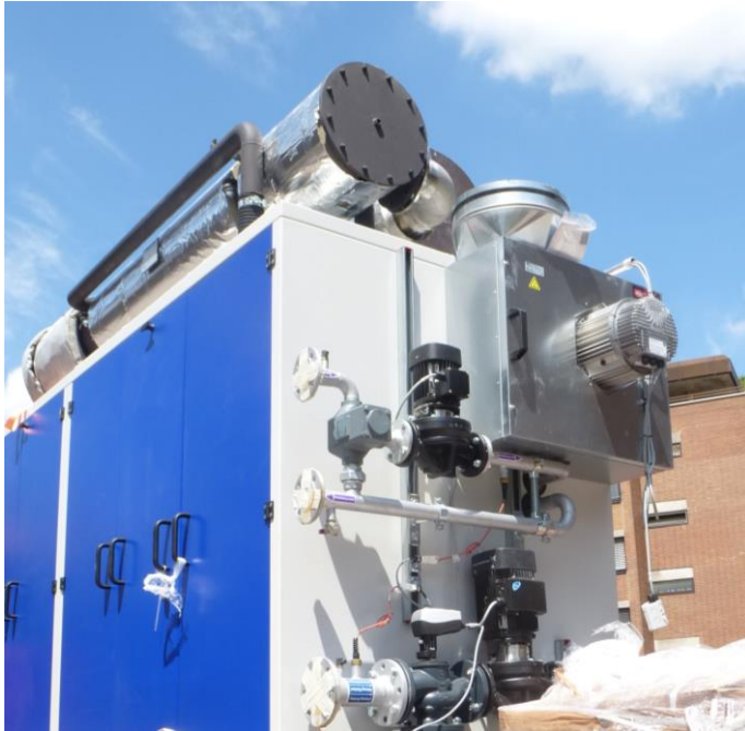
Installation des zweiten BHKW
